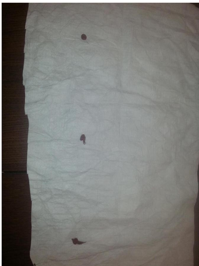
Складываем ровно тайвек и слегка прижимаем чтоб капля силикона стала плоской и склеила два слоя тайвека шершавыми сторонами внутрь. На те места где в нашем
